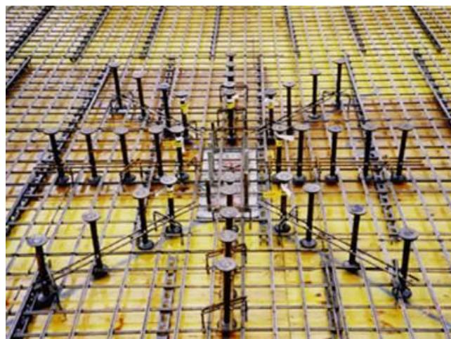
Рисунок 3.5 – Пример расстановки унифицированных сварных элементов, позволяющие избежать продавливания перекрытий в приопорной зоне
