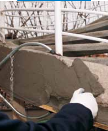
Нанесение MapegROUT 430 при помощи мастерка
