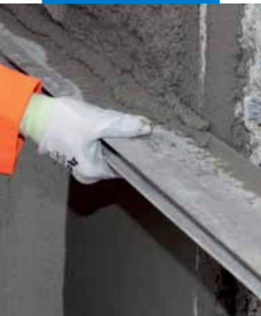
Выравнивание MapegROUT 430 при помощи правила
