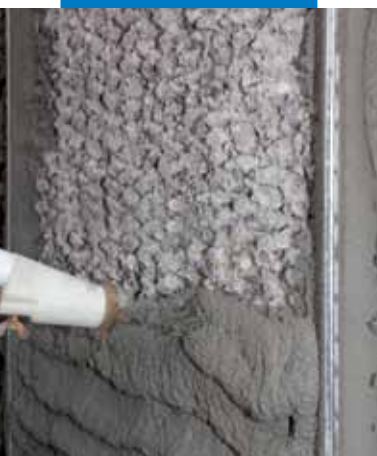
Нанесение MapegROUT 430 набрызгом
