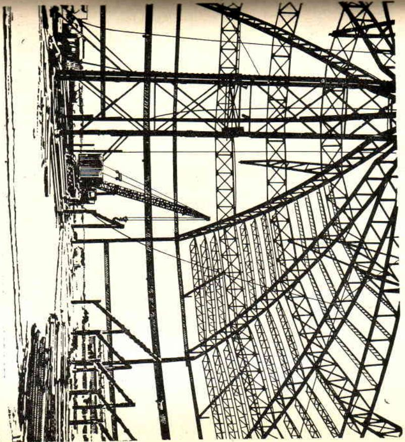
в стальных конструкциях в виде ребристого сферического купола с радиусом кривизны 85 м.
