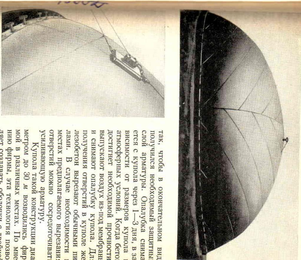
так, чтобы в окончательном виде получился необходимый защитный слой арматуры. Опалубка снимается с купола через 1—3 дня, в зависимости от размеров купола и атмосферных условий. Когда бетон достигнет необходимой прочности, выпускают воздух из-под мембрани и снимают опалубку купола. Для получения отверстий в куполе жеизобетон вырезают обычными пилами. В случае необходимости в местах предполагаемого вырезания отверстий можно сосредоточивать усиливающую арматуру.
