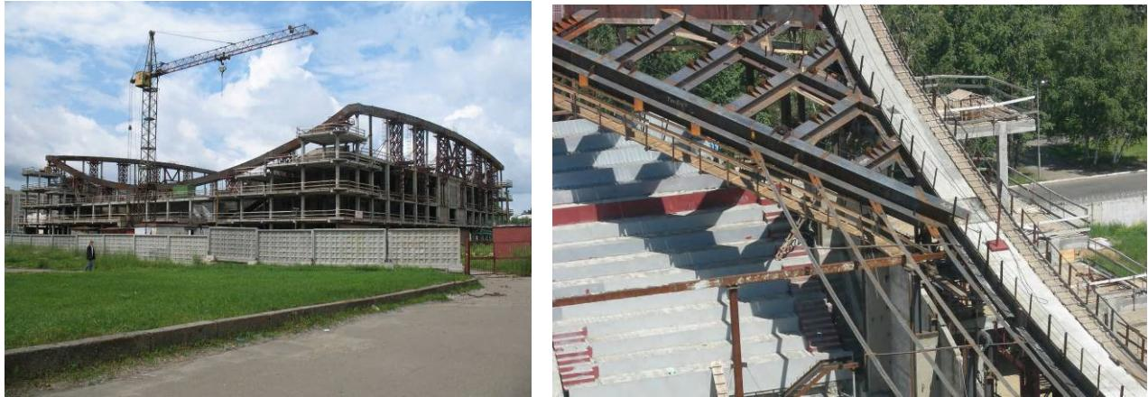
Рис. 4. а) Смонтированный опорный контур на временных опорах
