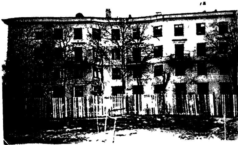
Рис 1.12 Аварийные деформации здания в результате проходки подземной выработки
