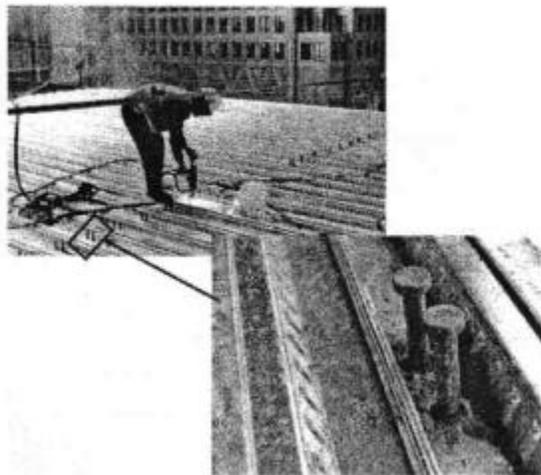
**Рисунок 15 – Установка стэд-болтов в перекрытия с помощью пистолета**
