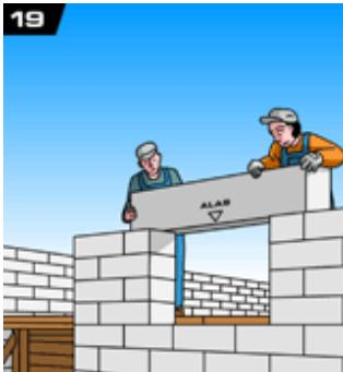
19. Для перекрытия оконных проемов рекомендуется использовать армированные газобетонные перемычки Н+Н Siporex. Рекомендуемая глубина опирания 300 мм с каждой стороны, а минимально допустимая - 200 мм.
