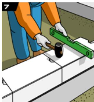
**7.** Установка каждого блока контролируется по уровню и шнуром-причалке. Для корректировки кладки блоков используется резиновая киянка.
