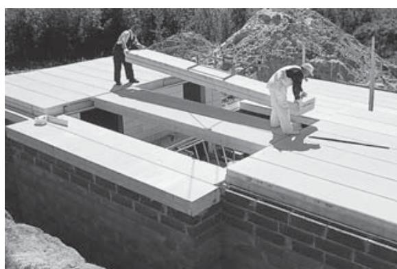
В отличие от междуэтажных, к ним не предъявляются требования по звукоизоляции, как от ударного, так и от воздушного шума (если подвал не предназначен для досуговых помещений).
