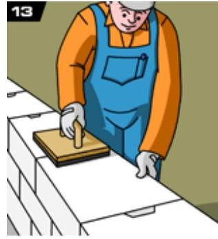
13. После укладки очередного ряда блоков поверхность кладки выравнивается с помощью терки. Между соседними блоками не должно оставаться перепадов уровня. Мелкие загрязнения и пыль удаляются щеткой.
