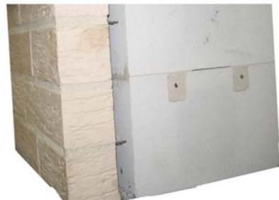
При использовании кирпичного наружного или внутреннего слоя в качестве несущего его толщина не должна быть менее 1,5 кирпича (380 мм), а глубина опирания перекрытий – 120 мм.
