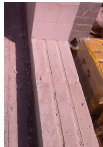
**Электрофреза** применяется для фрезерования пазов под укладку электропроводки, труб небольшого диаметра, арматуры.
