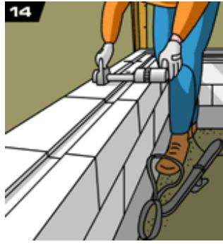
14. Первый и каждый 4-й ряд кладки рекомендуется армировать. Для этого прорезаются штробы (25x25) с помощью ручного или электрического штробореза. Необходимо удалить пыль из штробы, используя сметку или фен. Перед укладкой арматуры штроба заполняется клеем.
