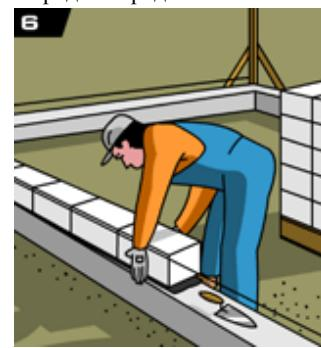
**6.** От выполнения кладки первого ряда блоков, во многом зависит качество всего дома. Ее выполняют особенно тщательно. Между фундаментом и кладкой необходимо выполнить гидроизоляцию по верхней отметке фундамента. Первый ряд блоков следует укладывать на выравнивающий слой цементно-песчаного раствора.
