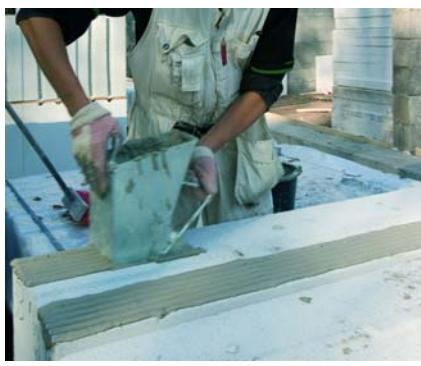
**Каретки** применяются для равномерного нанесения клеевого раствора Н+Н на горизонтальную поверхность газобетонных блоков. Каретки обеспечивают одинаковую толщину шва по всей ширине кладки. При кладке длинных и прямых поверхностей каретки значительно сокращают время ведения работ. Ширина каретки должна соответствовать ширине газобетонного блока Н+Н. Благодаря этому раствор наносится равномерно по всей поверхности блока и не стекает по бокам.
