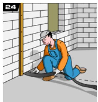
24. В основание внутренних стен необходимо укладывать мелкопористую битумную полимерную ленту. Для улучшения звукоизоляции в месте примыкания к боковой стене рекомендуется устанавливать уплотняющую ленту из мелкопористого материала.
