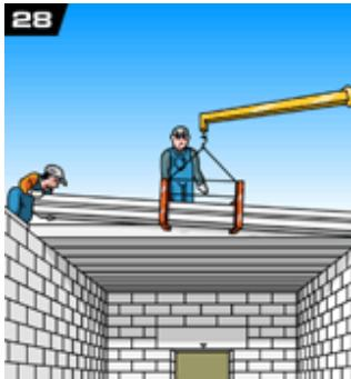
28. Для разгрузки и монтажа плит перекрытий используют специальные траверсы.
