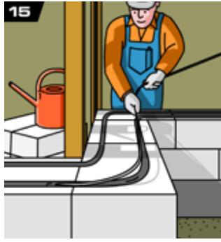
15. На углах стен штробы делаются с закруглением. Для армирования используют стальные прутки диаметром 8 мм, которыегибают по месту, используя специальный инструмент или ручные приспособления. Прутки вдавливаются в штробы. Клей должен полностью покрывать арматуру. Излишки клея удаляются.
