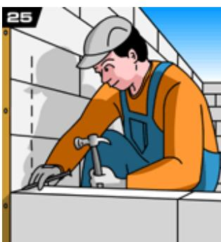
25. В каждом втором ряду необходимо связывать внутреннюю и боковую стены. Для этого применяются алюминиевые или нержавеющие стержни (гвозди). Также можно использовать нержавеющие анкера/скобы, ранее вмуренные в боковую стену или оцинкованную перфополосу.
